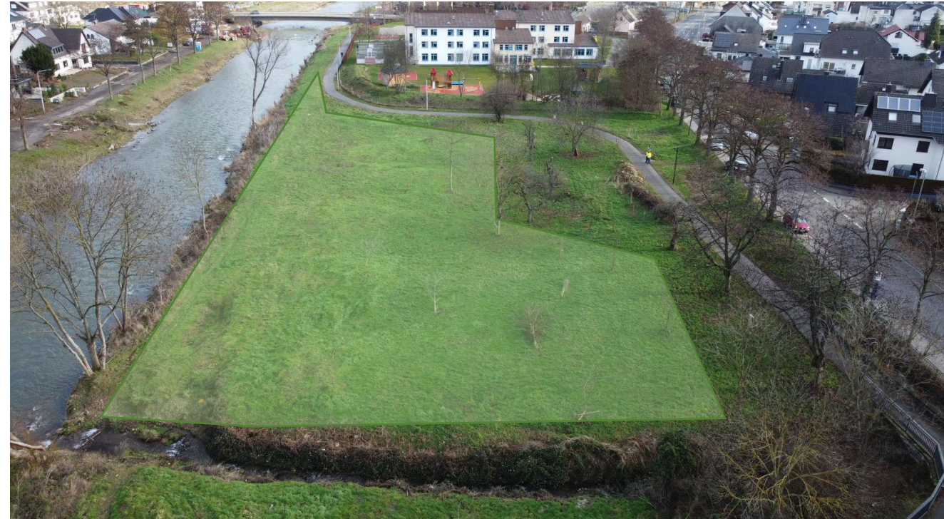
Vorlandabtrag rechtes Ufer ab Spätsommer 2025
