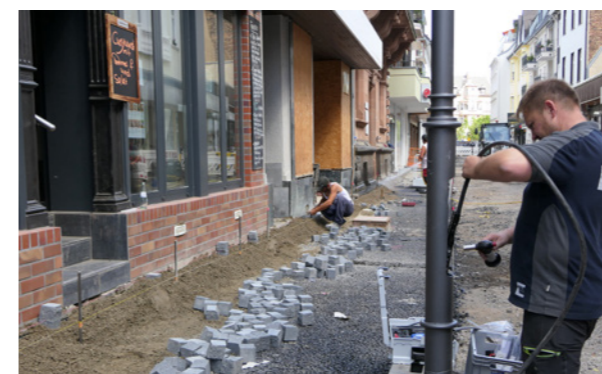
Baufortschritte in der südlichen Poststraße (Ahr-Foto, Hans-Jürgen Vollrath)
