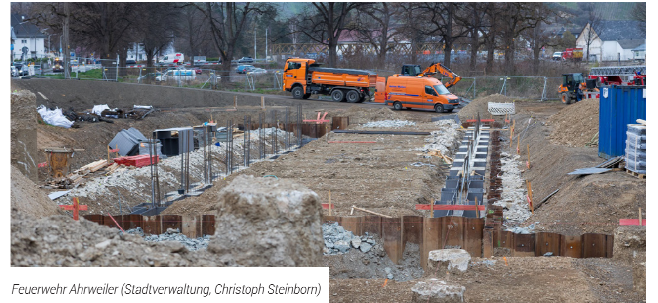
Arbeiten an der Bachemer Brücke – Frühjahr 2026 (Stadtverwaltung, Christoph Steinborn)
