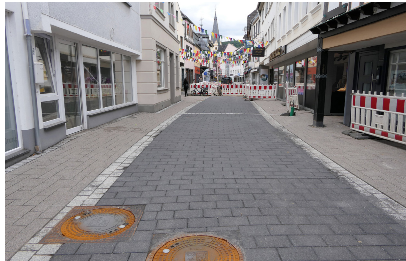
Niederhutstraße – Fortschritte im Juli 2025 (Ahr-Foto, Hans-Jürgen Vollrath)
